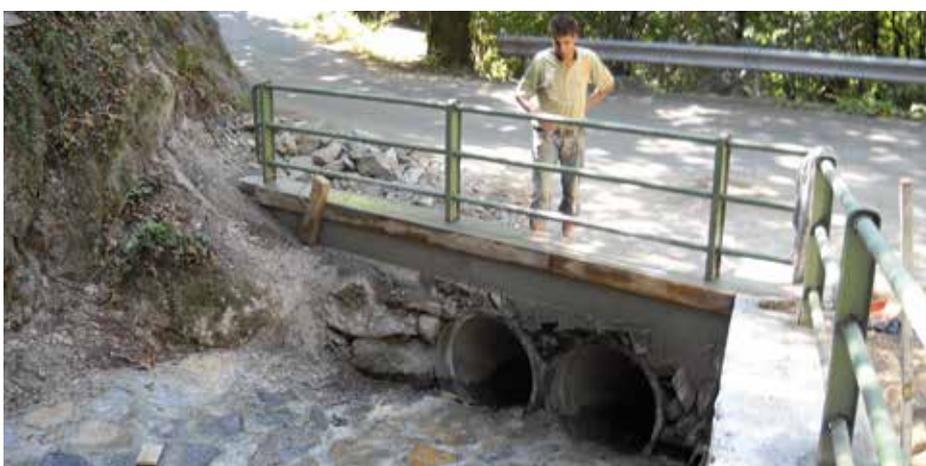
Quasi a Camnasco, abbiamo realizzato un intervento di manutenzione straordinaria "ridotta" sul torrente Valle di Mulini, con miglioramento del fondo stradale e corrivamento delle acque meteoriche. Contestualmente si è provveduto anche ad allargare la curva in prossimità del bivio Monti/Camnasco.
