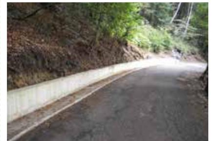
I lavori nella frazione dei Monti sono stati molteplici. Necessaria, ad esempio, la cunetta realizzata sotto la località dei Monti di Gallio, prosecuzione di quella già esistente ma con l'inserimento questa volta anche di tubi drenanti, per contenere la copiosa quantità d'acqua che d'inverno, causa il ghiaccio, rende impossibile il transito. Contestualmente a questo intervento si sono avviati altri lavori di sistemazione nella frazione di Treccione.
