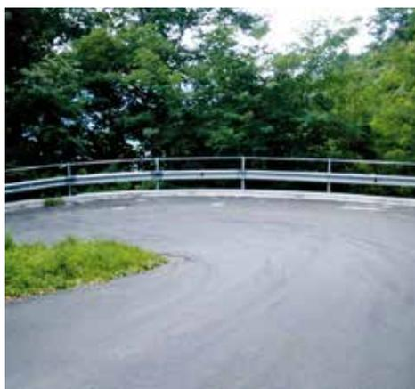
Questo intervento si è reso necessario per rendere più sicura una curva pericolosa. Si è provveduto alla sostituzione del vecchio guard rail e ad "ammorbidire" la curva rifacendo il manto stradale.
