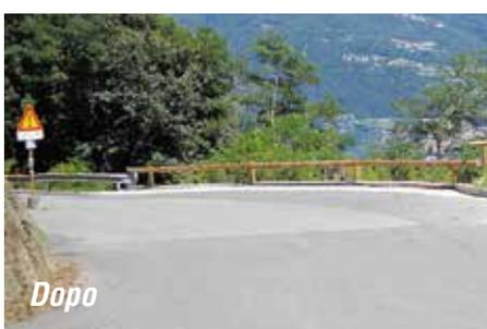
un rinforzo del muro che sostiene la strada a valle. Con la posa di un banchettone in cemento armato, rinforzo definitivo della carreggiata, lo smaltimento delle acque piovane e l'inserimento di nuovi guardrail, la zona ha cambiato decisamente aspetto.
