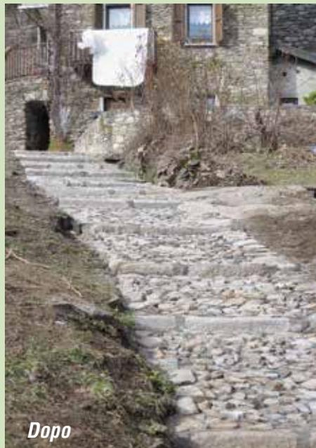
Grazie a questo intervento realizzato nel 2010, abbiamo provveduto a sistemare la vecchia stradina lastricata, e decisamente ammalorata, che conduceva alla frazione di Roncate, sostituendola con una scalinata in pietra che, oltre ad essere funzionale, ben si inserisce nell'aspetto paesaggistico della zona. La successiva approvazione del PGT ha èoi ribadito anche la fattibilità di una strada carrozzabile di collegamento alla parte a valle della frazione di Roncate.
