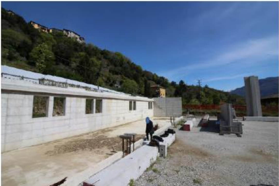
Vedute generali dell'area di cantiere
