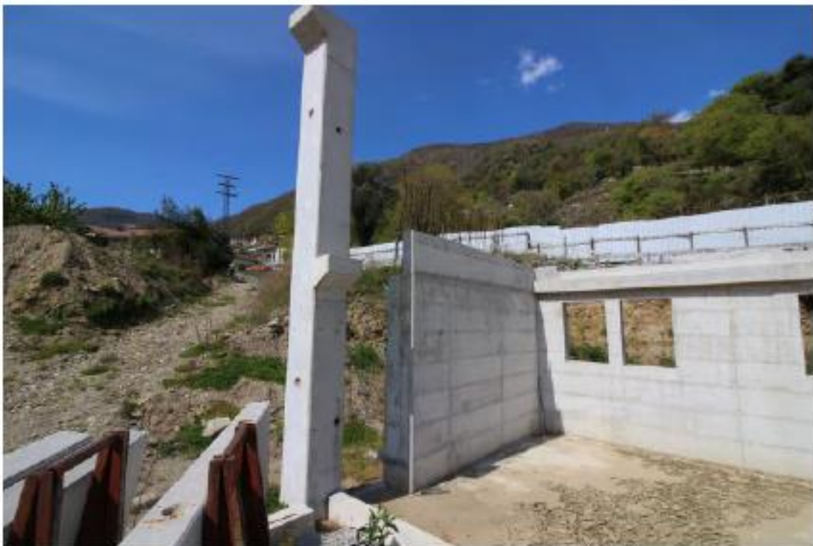
Vedute generali dell'area di cantiere
