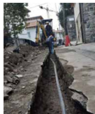
Lavori rifacimento tubazione acquedotto Via Cesare Cantù - via Regina Margherita (160 metri circa)
