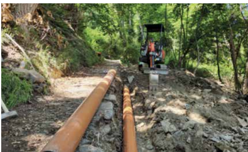
Rifacimento tubazione acquedotto Via Santa Maria (500 metri circa)
