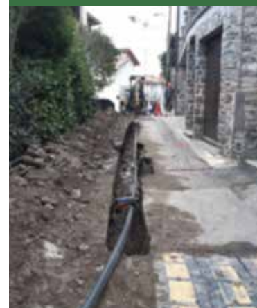
Lavori rifacimento tubazione acquedotto Via Cesare Cantù - via Regina Margherita (160 metri circa)
