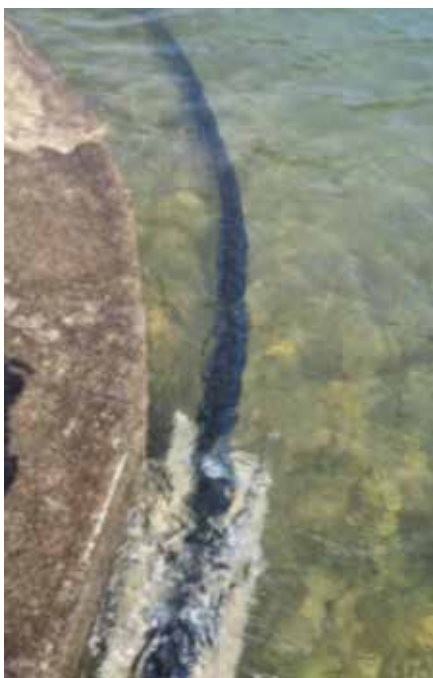
Interconnessione impianto di emungimento a lago con la rete acquedotto. L'intervento garantirà maggior continuità nel servizio di fornitura.
