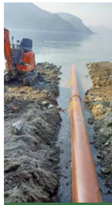
Realizzazione nuovo troppo-pieno stazione di sollevamento Molvedo.
