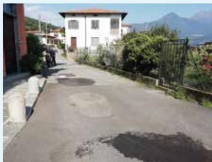
L'Amministrazione comunale ha pertanto deciso, al fine di risolvere le problematiche di procedere al rifacimento del tratto iniziale di acquedotto mediante posa di nuova tubazione di categoria superiore e ad una profondità maggiore al fine di evitare le frequenti rotture. Si provvederà di conseguenza al
